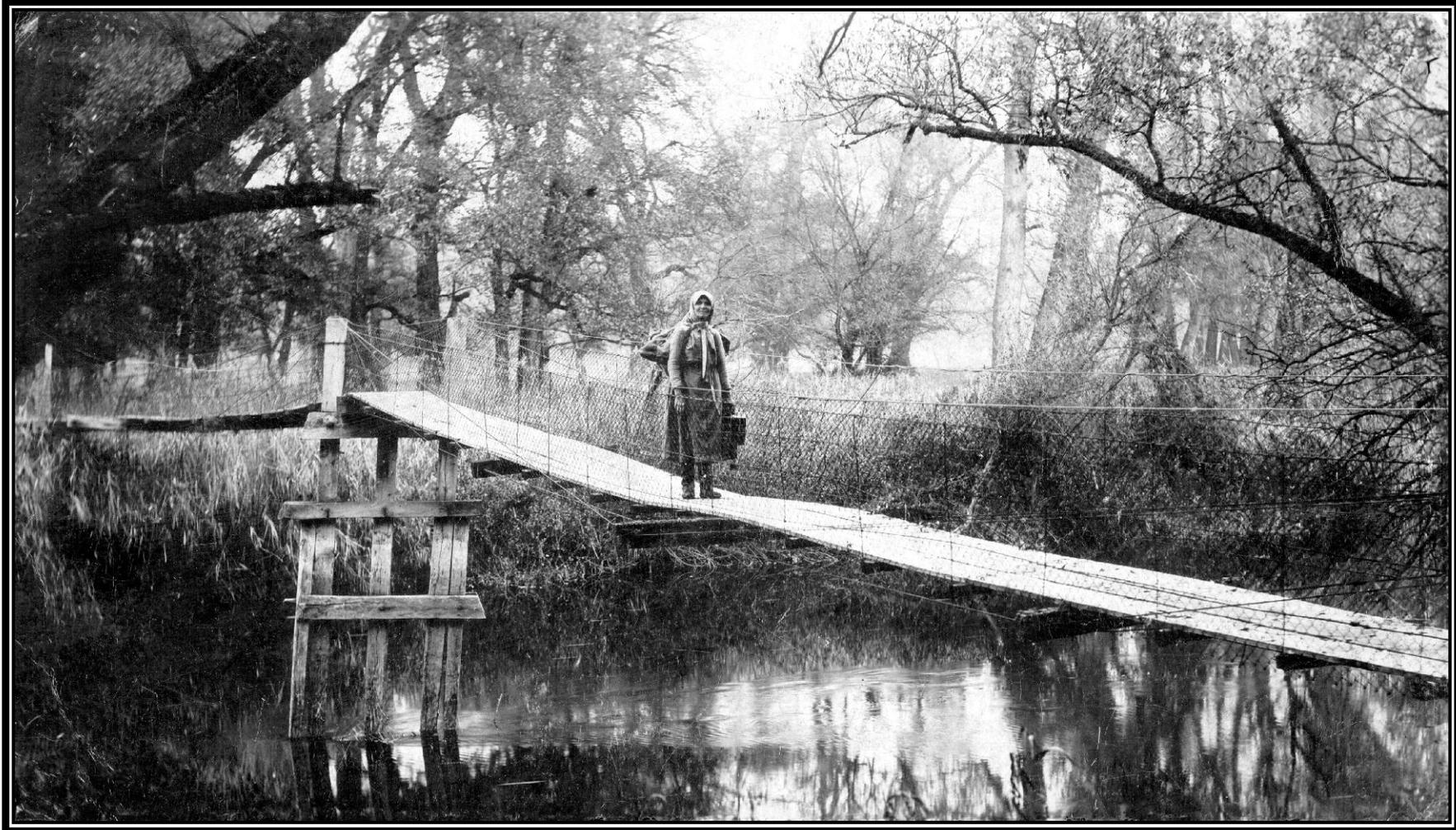
Hutscherter Steg - eine Draht-Seilbrücke als Vorläuferin der späteren Holzbrücke in der Kohlfahrt als Verbindung Bernhardsthal - Pohanska. Eine sehr flache Grobschotterschwelle knapp unter der Brücke eignete sich früher sicher als Furt. Auch dieser Steg bot nur einen bedingt hochwassersicheren Übergang. Der Steg bestand bis 1911.
