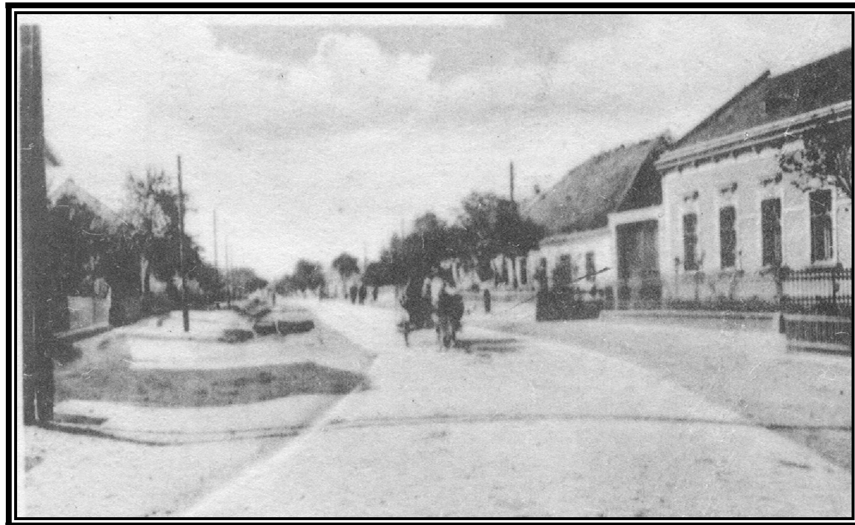
Von einer mit 3 Fotos versehenen Postkarte, datiert 1921. Strommasten weisen auf die beginnende Elektrifizierung hin. Nr. 15 hat noch ein Strohdach und die Einfahrt ist nicht überdacht. Nr. 13 ist noch nicht aufgestockt und durch Bäume verdeckt.
