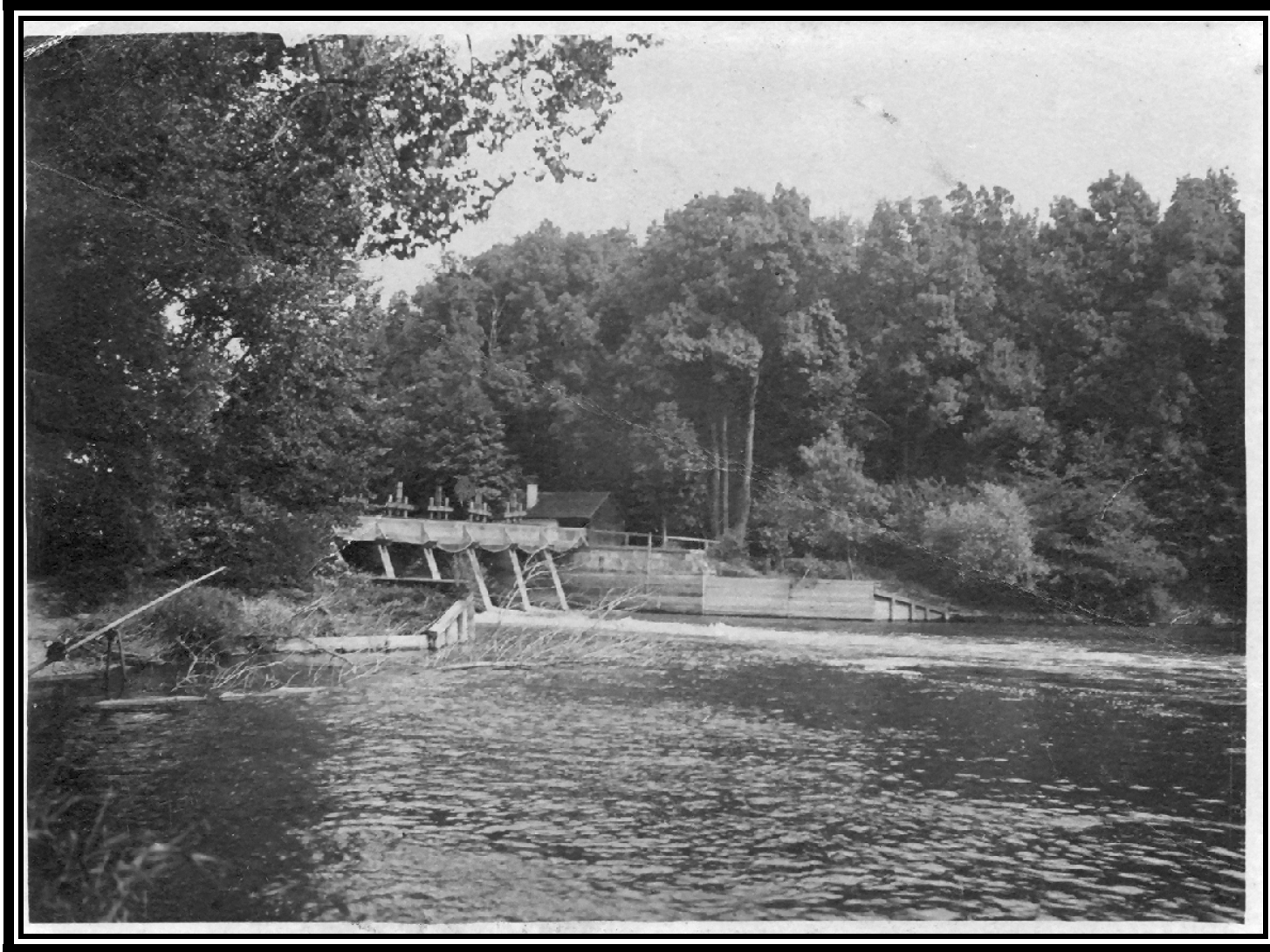
Die bis 1945 bestehende Wehr. Unter der Wehr wurde eine angeblich über 20 m tiefe Grube ausgeschwemmt. Das Material bildete eine beachtliche Insel. Noch nach dem Krieg war diese Stelle wegen der angenehmen Kreisströmung und dem feinen Sand auf der Insel eine beliebte Badestelle.
