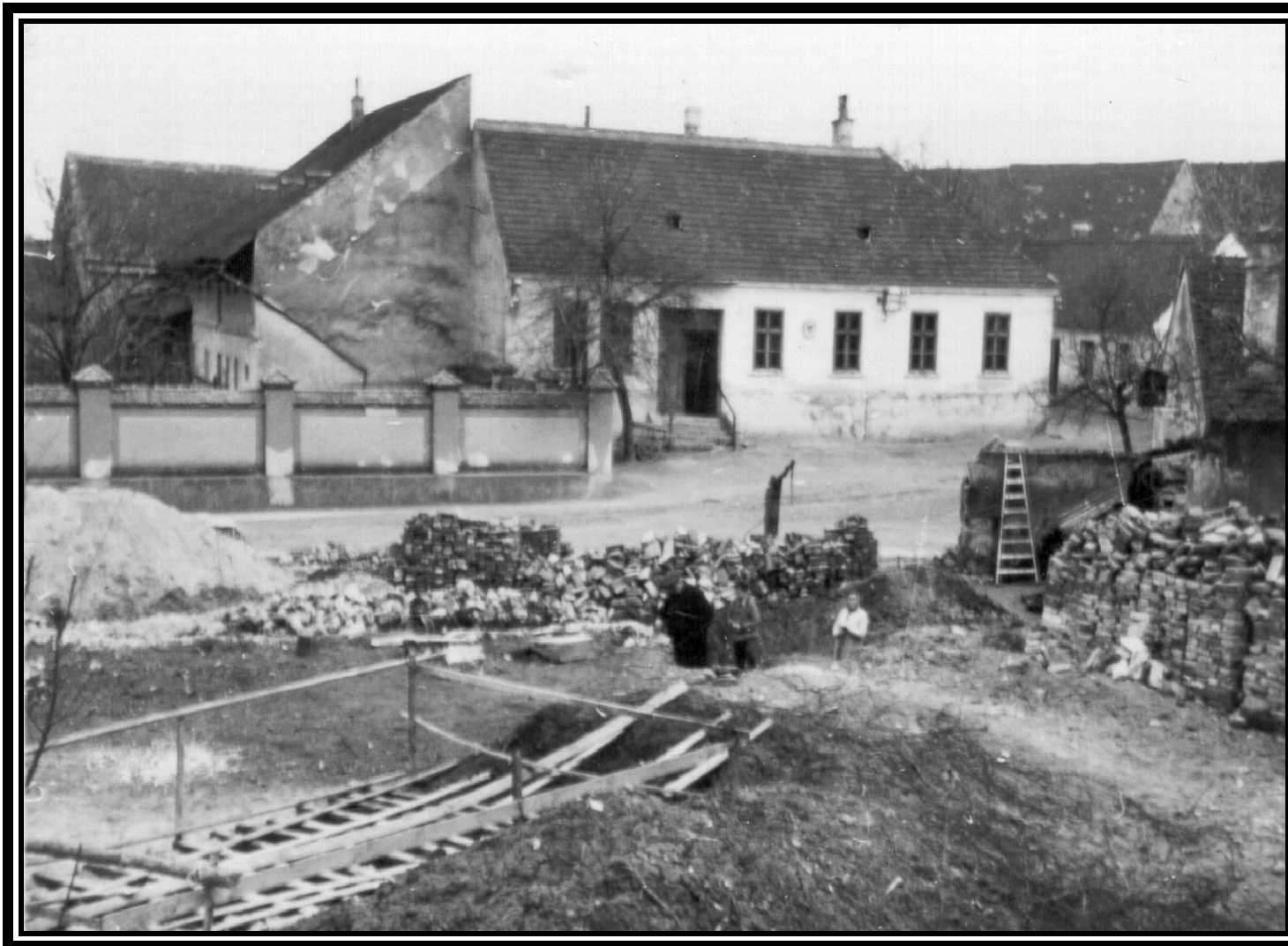
Etwa 20 Jahre später – 1953 – Grundaushub für das neue Pfarrheim. Der Gartenbrunnen steht noch. Rechts vom Hauseingang des Gemeindehauses residierte die Post, das Postschild hängt zwischen erstem und zweiten Fenster. Die beiden Fenster links gehörten zur Wohnung. Gleich nach dem Krieg Dr. Majewsky, später Bednarik.
