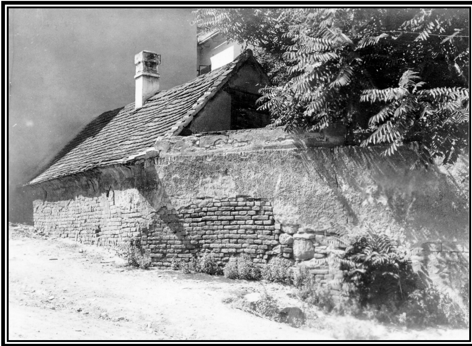
Ein Detail vom Museumsplatz zwischen Pfarrheim und Schule, später war hier die Garage der Rettung. 1952 wurde die ehemalige Waschküche des Pfarrhofs abgerissen und über einer Garage ein Rohbau für eine Mesnerwohnung errichtet.
