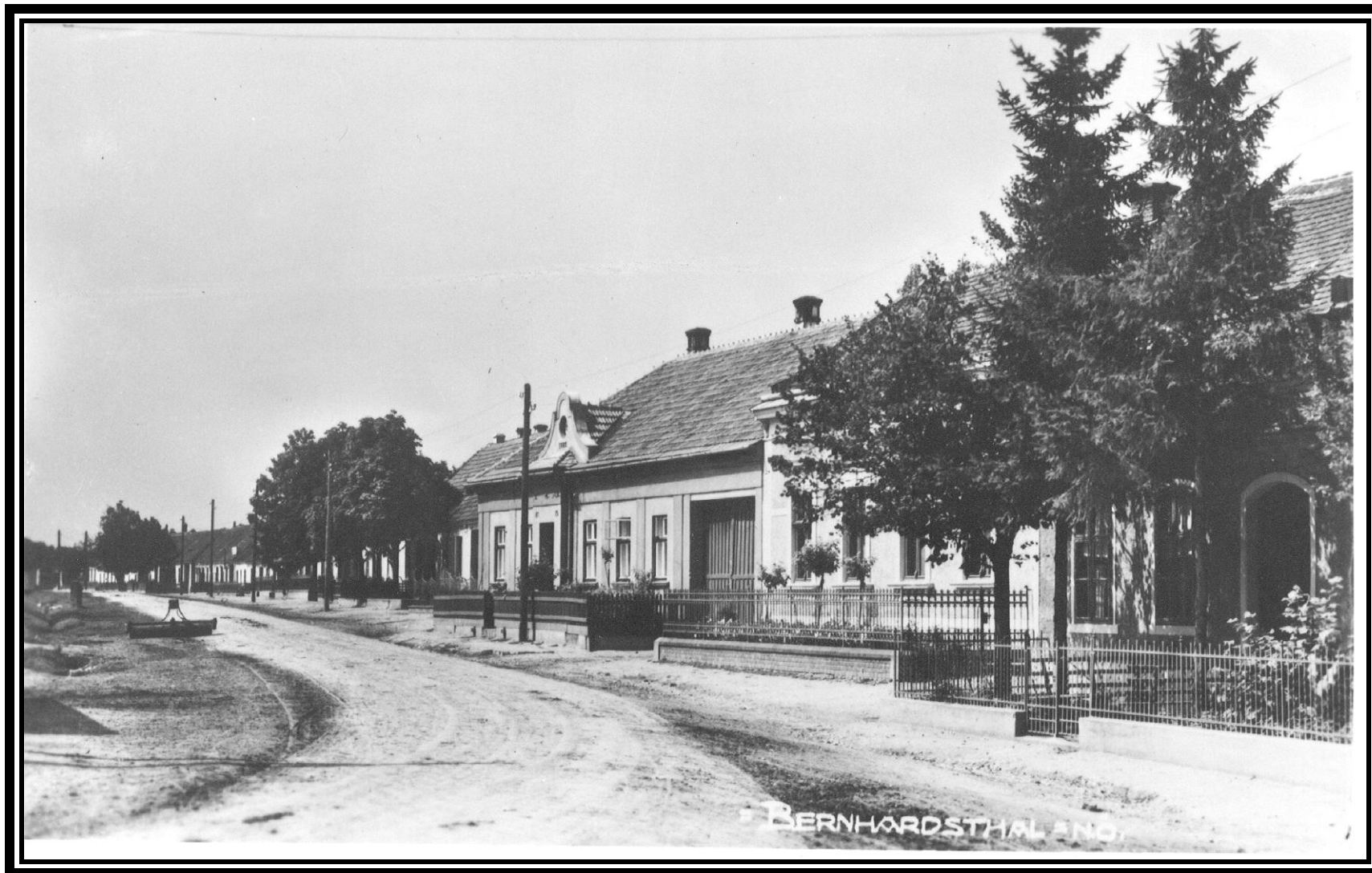
Postkarte, Nr. 15 schon vollendet, Nr. 13 noch nicht aufgestockt, sonst müßte es sichtbar sein, Nr. 17 hat einen breiten (!) Vorgarten mit 2 Bäumen hintereinander und einen gewölbten Eingang. Auf der südlichen Straßenseite ist der Graben frisch geputzt, am Straßenrand steht eine Holzwalze.
