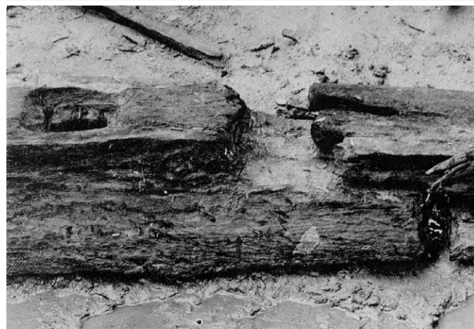
Abb. 11: Verbindung Balken 1 — Balken 2 von NO.
