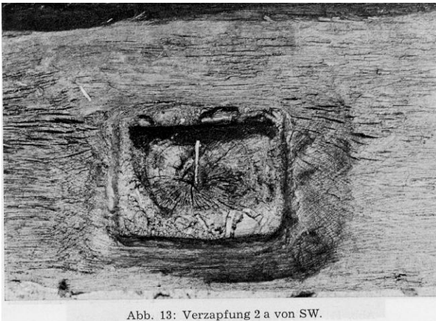
Abb. 13: Verzapfung 2 a von SW.
