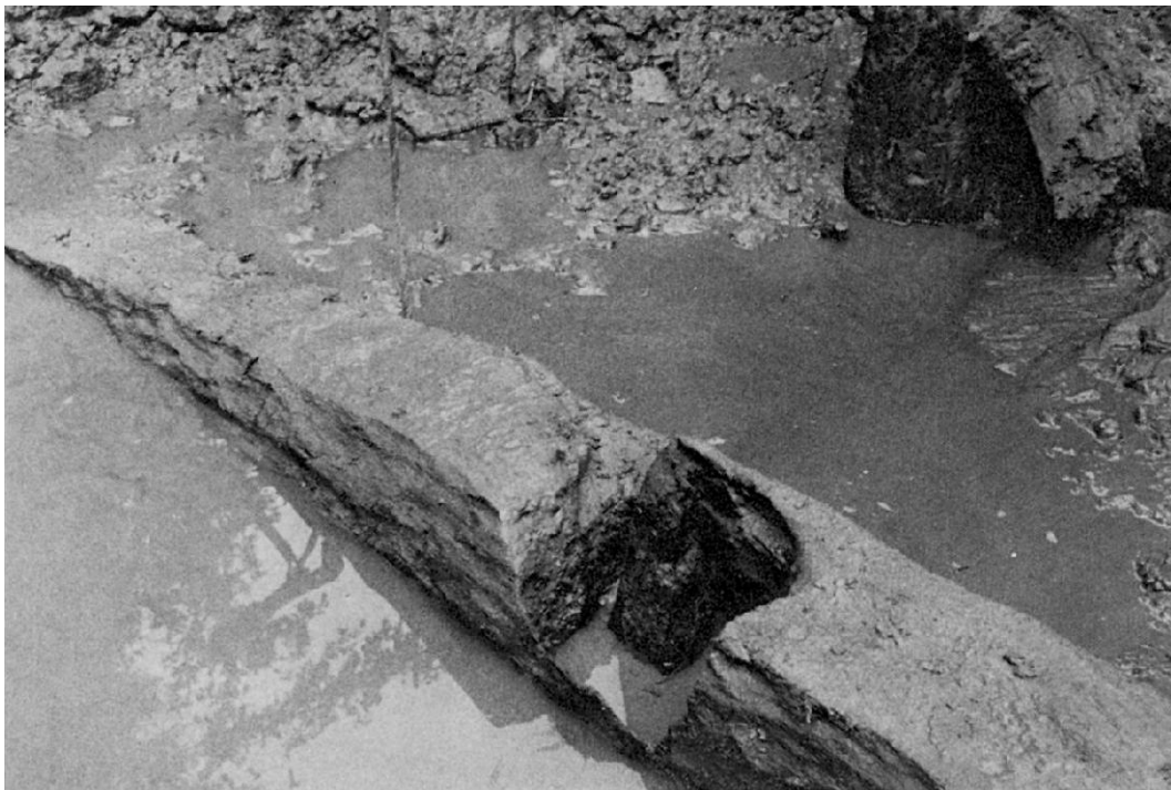
Abb. 6: Balken 1, Verzapfung 1 a und Pfosten 12 von S.
