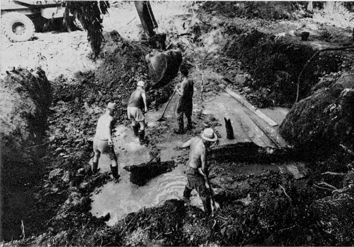
Abb. 2: Wassermühle zu Beginn der Freilegungsarbeiten.
