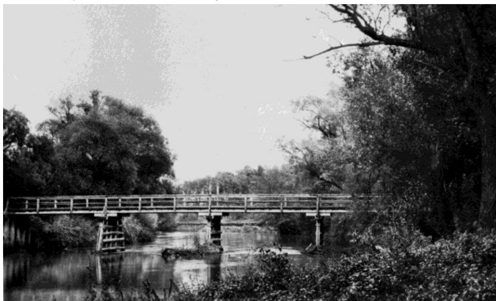
Abb. 24 Thayabrücke, an Stelle des Drahtsteges
