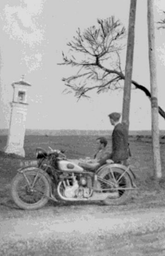
Abb. 41 Wehrlehenkreuz vor der Abräumung
