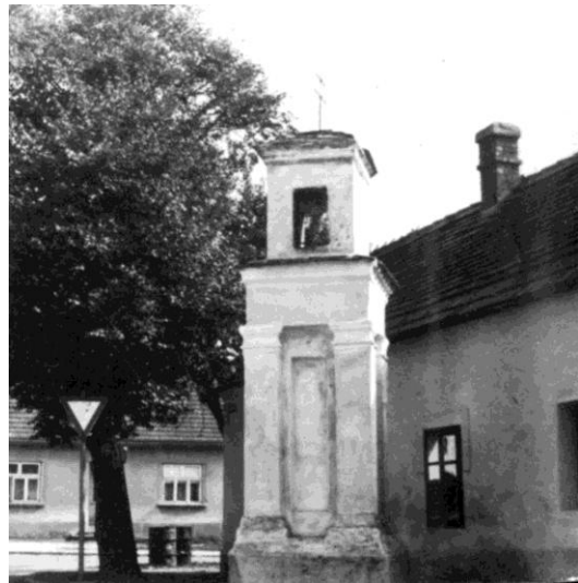
Abb. 27 Marterl am ehemaligen südlichen Ortsende
